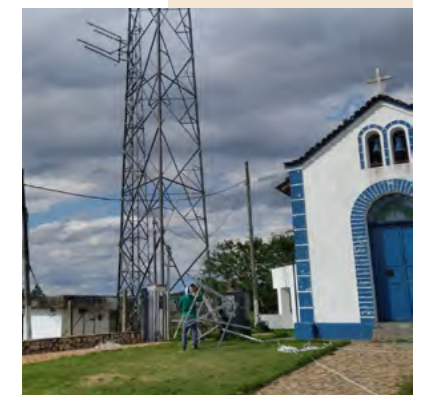
Retirada das antenas
